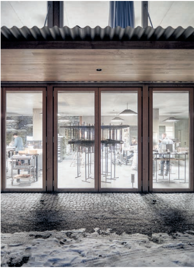
Im Sommer öffnet sich die Modellbauwerkstatt weit auf den Vorplatz. Ein Vordach schützt ihn.
